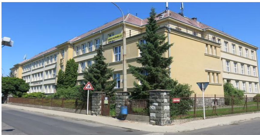
Obr.1 – ZŠ Chabařovice, hlavní budova
